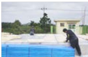
⑦ 바닥판 설치
