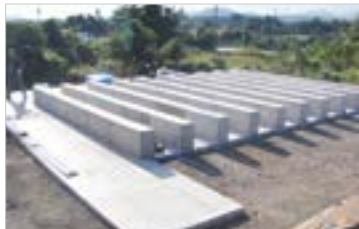
⑤ 기초콘크리트 확인
