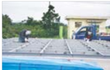
⑥ Base Frame 작업
